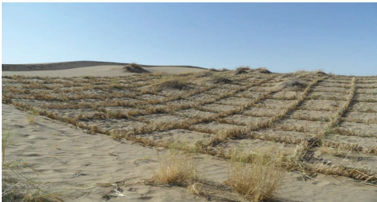
Рис. 3. Закрепление подвижных песков
